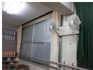
本館南側の様子
