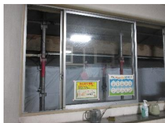
本館廊下側の様子
